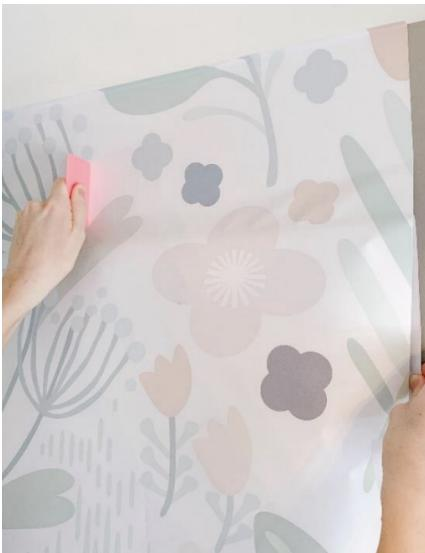
Uhvatite vrh bijele podloge koju ste odvojili sa zadnje trane. Polako povlačite bijelu podlogu prema dole pri čemu možete koristiti karticu da je utisnete u zid. Karticu krećete sa lijeva na desno i istiskujte mjeđuriće prema rubovima dok držite traku blago zategnutom. (TIP: ovdje će vam super doći pomoć prijatelja) Čete formiranjem mjeđurića tako što ćete karticu kretati polako.
