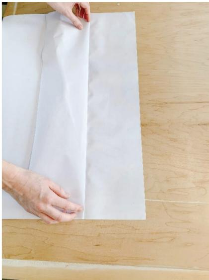
Postavite traku na čistu površinu i okrenite je prema podu. Odlijepite bijelu podlogu od vrha tapete prema dnu otprilike 30cm. Presavijte odvojeni dio bijele podloge.
